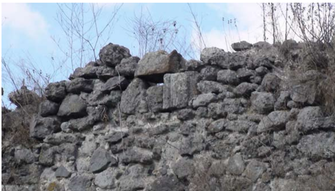
Malá obranná strieľňa v korune múru severnej steny je tvorená z kamenných kvádrov. Tieto detaily pomali zanikajú vplyvom rozpadu muriva.
