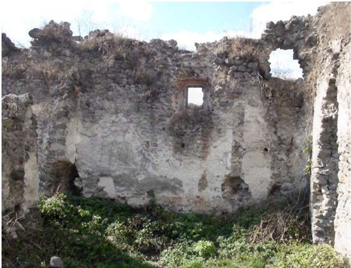
Západná stena paláca z interiéru. Vľavo dole štrbinové okno, v strede okno s kamenným ostením a deštruovaným záklenkom, vpravo hore deštrukciou zväčšený otvor pôvodných obranných strielní.
