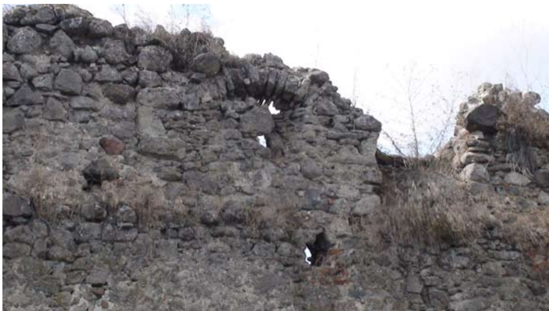
Zamurovaná, rozpadom ohrozená strieľňa v korune múru západnej steny.
