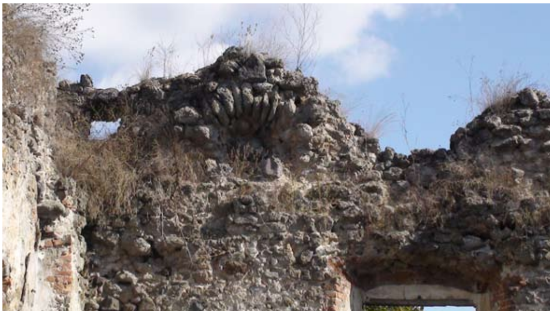
Zachovaná, ale postupným rozpadom ohrozená obranná strieľňa v korune múru východnej steny.
