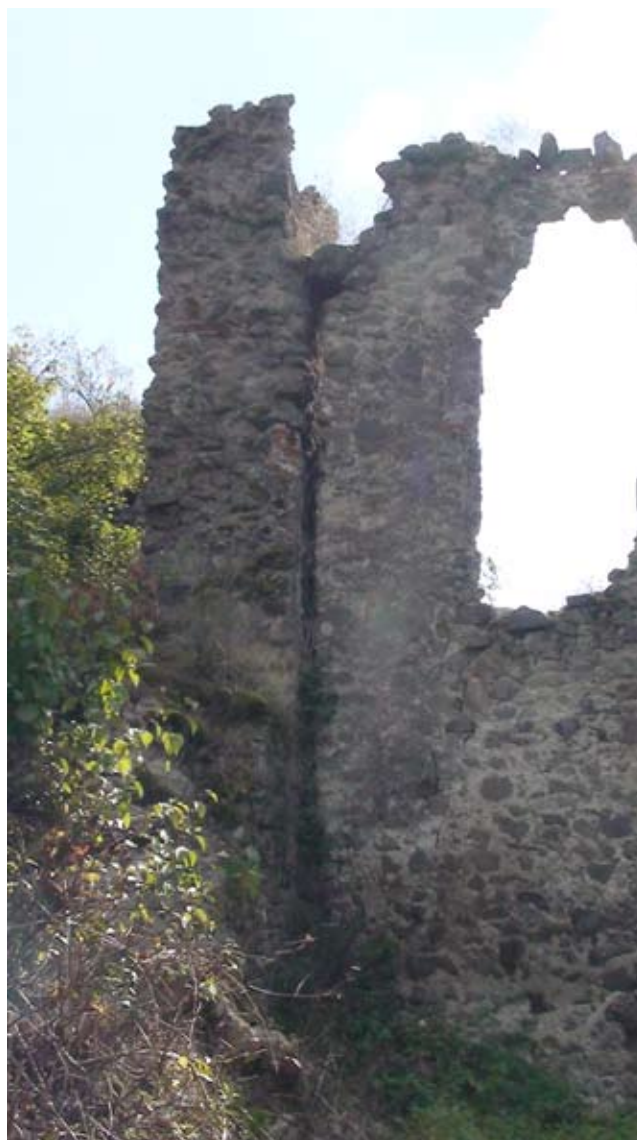
Výrazná škára medzi východným múrom opevnenia a stenou severného paláca dokazuje, že budova bola dodatočne vstavaná do hmoty nádvorja.
