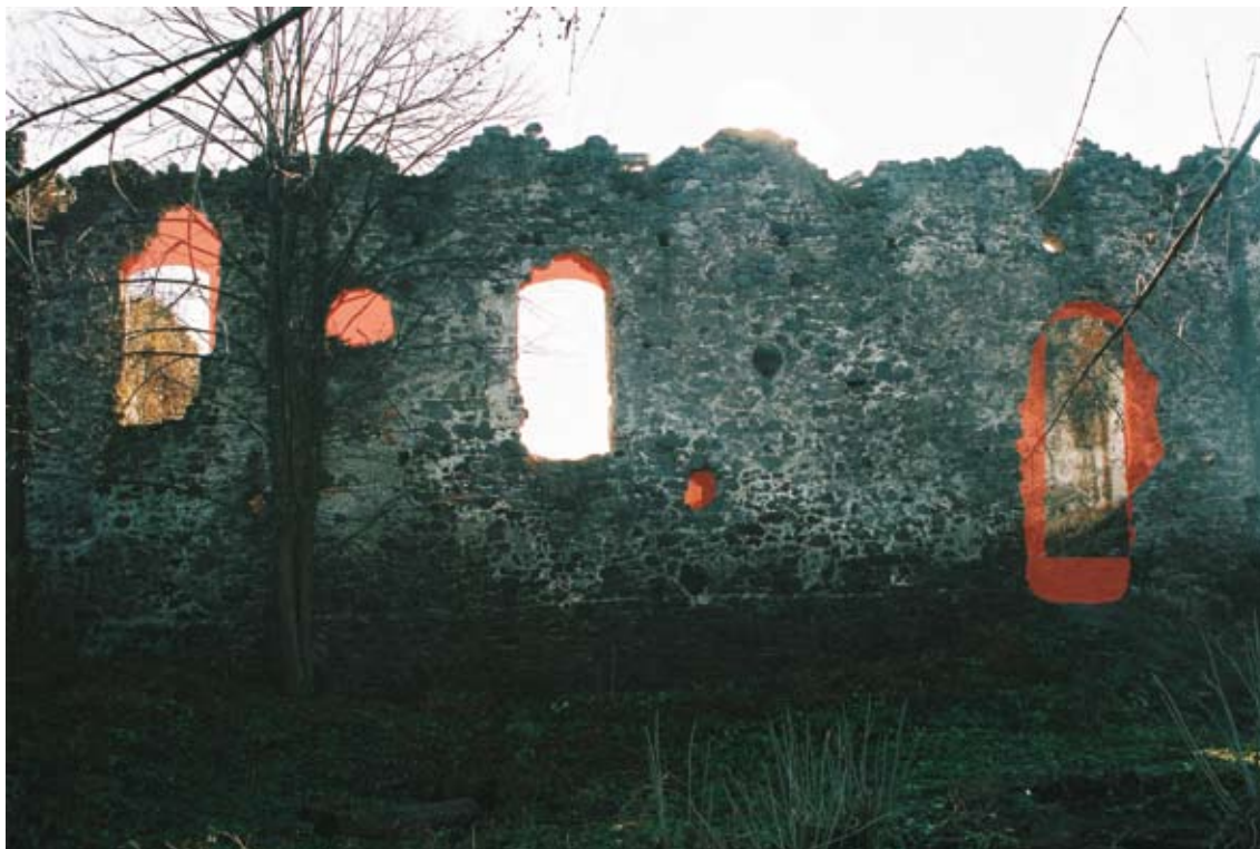
Severná stena paláca s vyznačeným rozsahom zamýšľaných rekonštrukčných prác.
