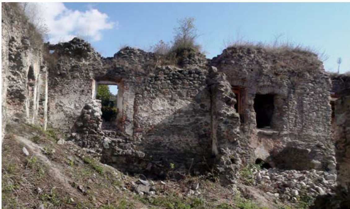
Na zachovanej interiérovej priečke paláca sa zachoval odtlačok kamennej klenby prízemia.
