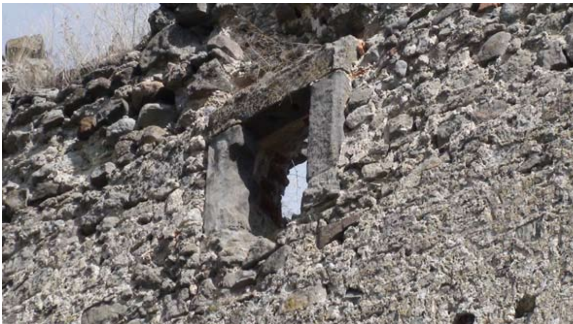
Kamenné ostenie okna v západnej stene severného paláca.
