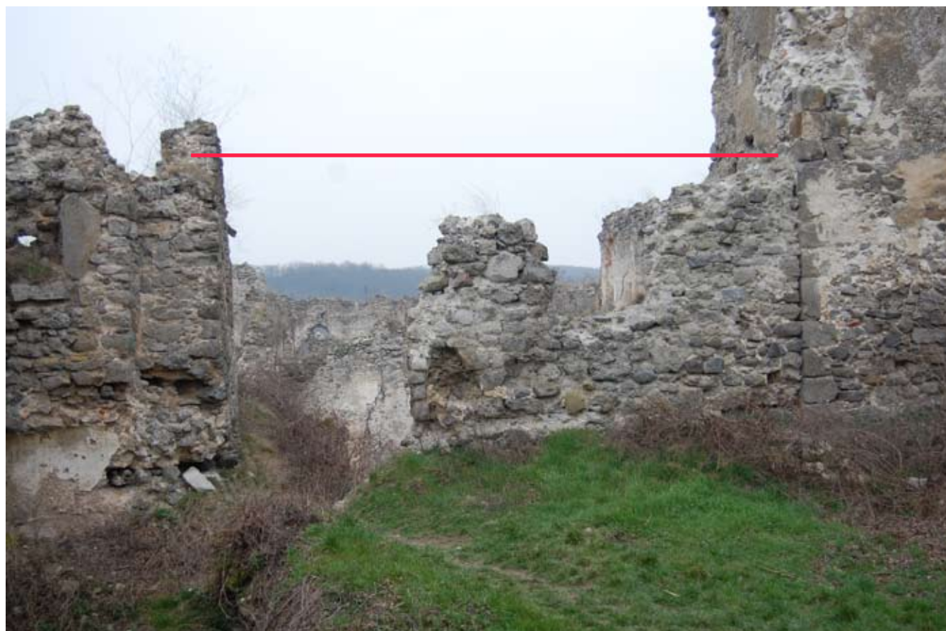
B: Obytná prístavba západne od hlavnej veže pri pohľade z bastiónu. Červenou čiarou je naznačená výška, kde by začínala pultová strecha
