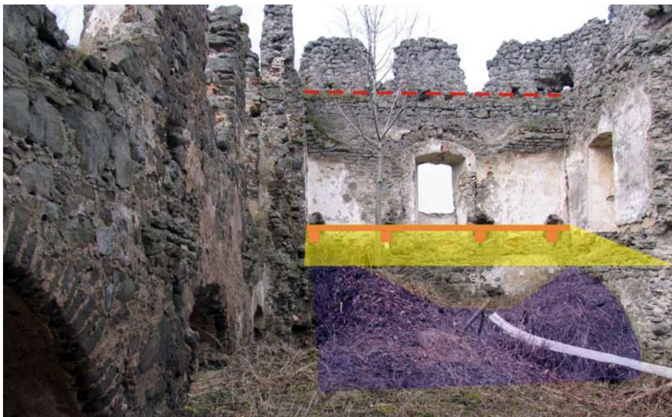
B: Západná veža Modrou vyznačené odstránenie sutín, žltou pultová strecha s uchytaním v trámových kapsách. Červená prerušovaná čiara - druhá alternatíva umiestnenia pultovej strechy.
