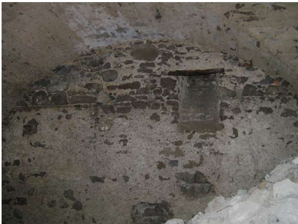
B: Prvé podlažie veže so zachovanou klenbou, v západnej stene je pôvodný vetrák.
