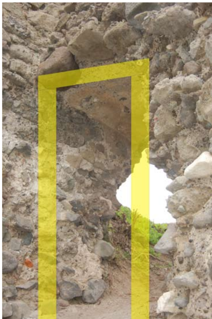
B: Západná veža Vyznačenie zamýšľaného osadenia drevenej zárubne do otvoru výpadnej bránky v SV rohu veže.
