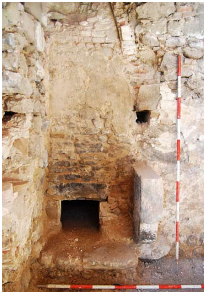
A: Tretia brána. Interiér - pohľad na chlebovú pec so zvyškami sopúchu.
