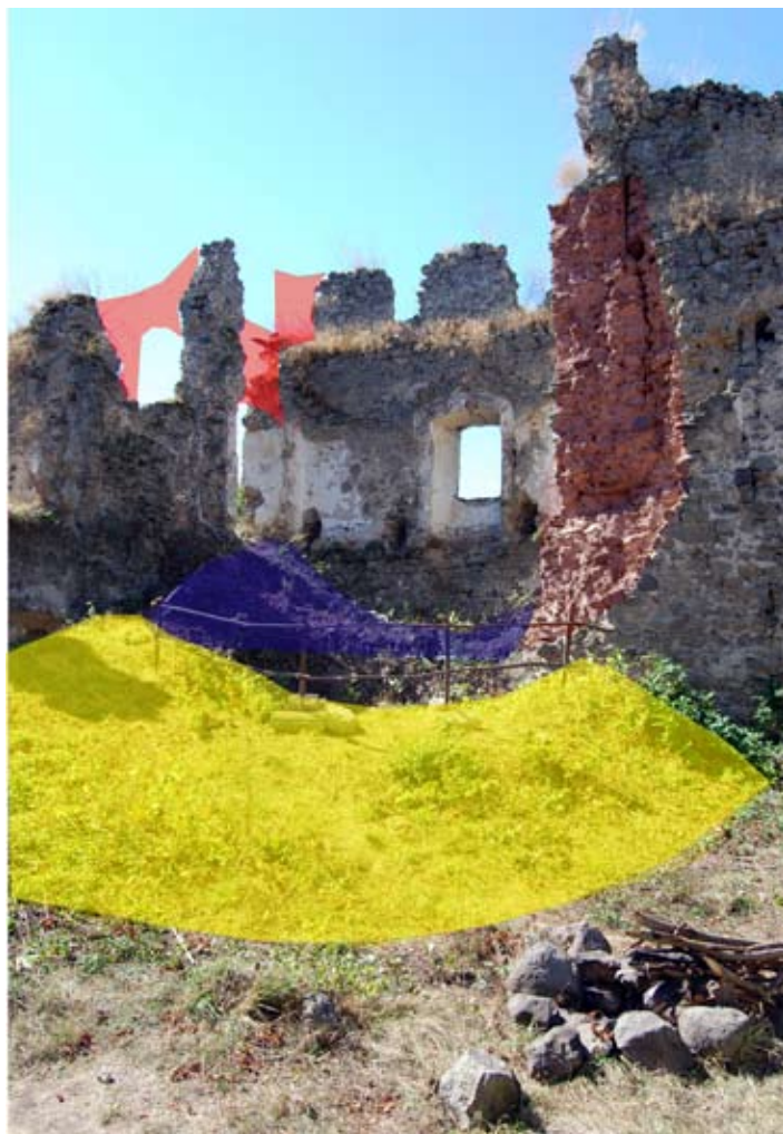
A: Západná veža. Pohľad do interiéru. Žltou farbou odstránenie sutiny v exteriéri, Modrou v interiéru. Červenou doplnenie muriva.
